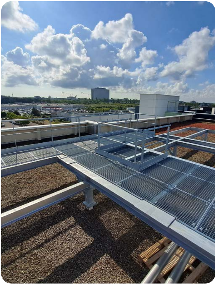
CPAM du Calvados - Charpente en toiture
